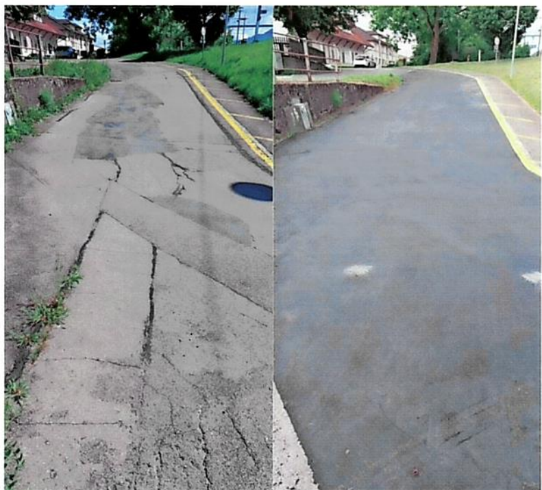
Bild 8: Zu sanierende Fläche (links) und nachdem sie mit einer kalten Dünnschicht, die Kohlenstoff enthält, saniert wurde (rechts)
