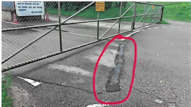
Bild 7: Unter Zugabe von Kohlenstoff reparierte Zufahrt eines Kieswerkes
