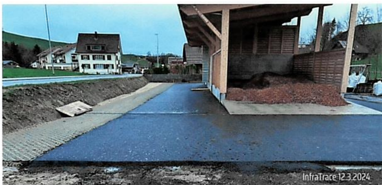
Bild 10: Klimaneutrale Tragdeckschicht
