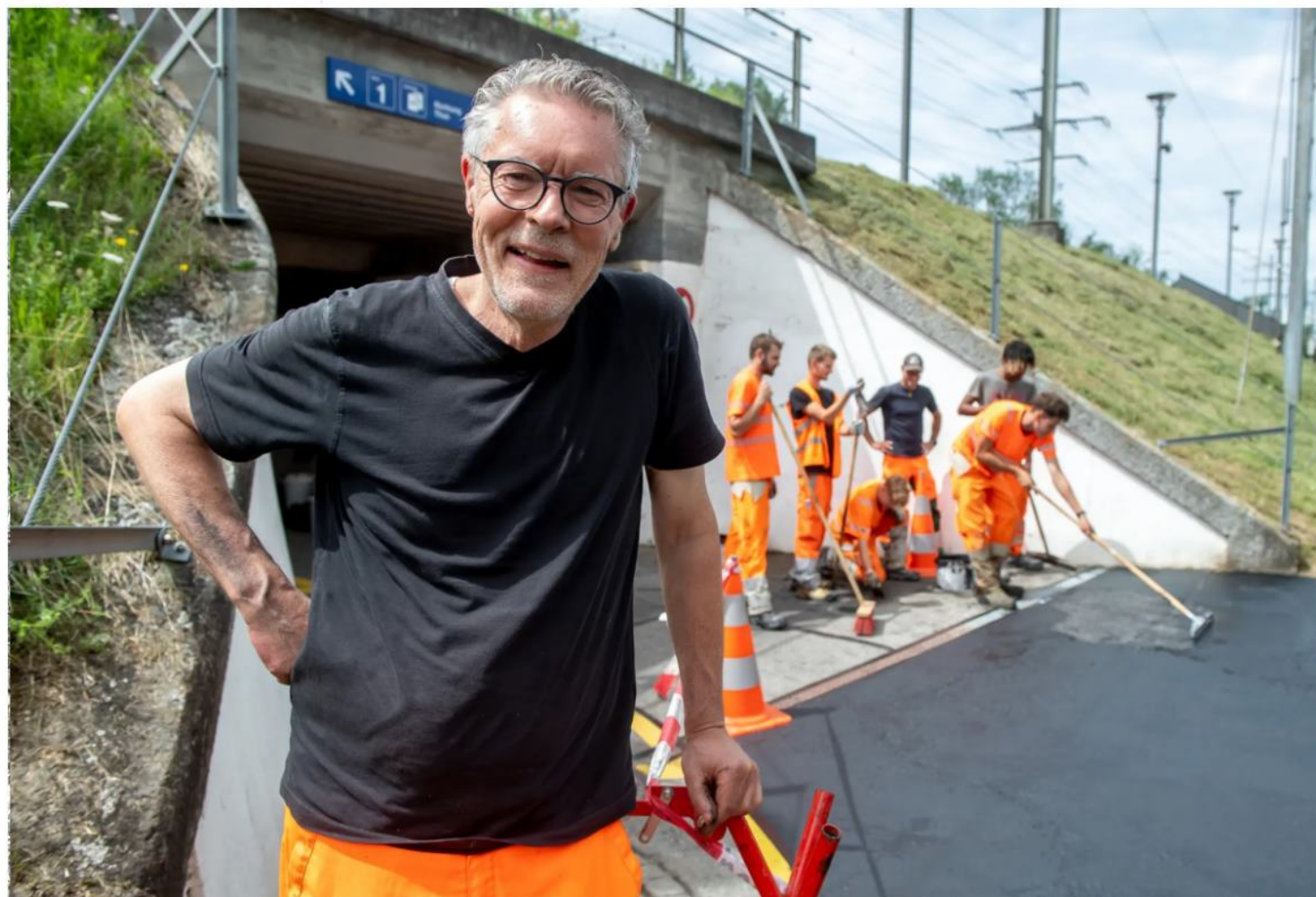
Roland Christen und ein Team von Lernenden der Baufirma Marti AG erneuern den Strassenbelag bei der Unterführung beim Bahnhof Kiesen mit einem Klimabaustoff. Foto: Patric Spahni
